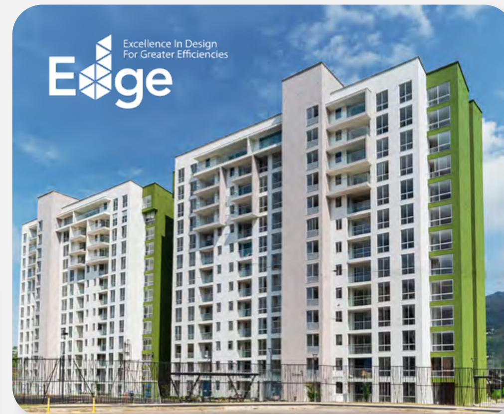
Olmo / Mayor a VIS Certificado Edge Núcleo Constructora S.A.S. Dosquebradas, Risaralda
