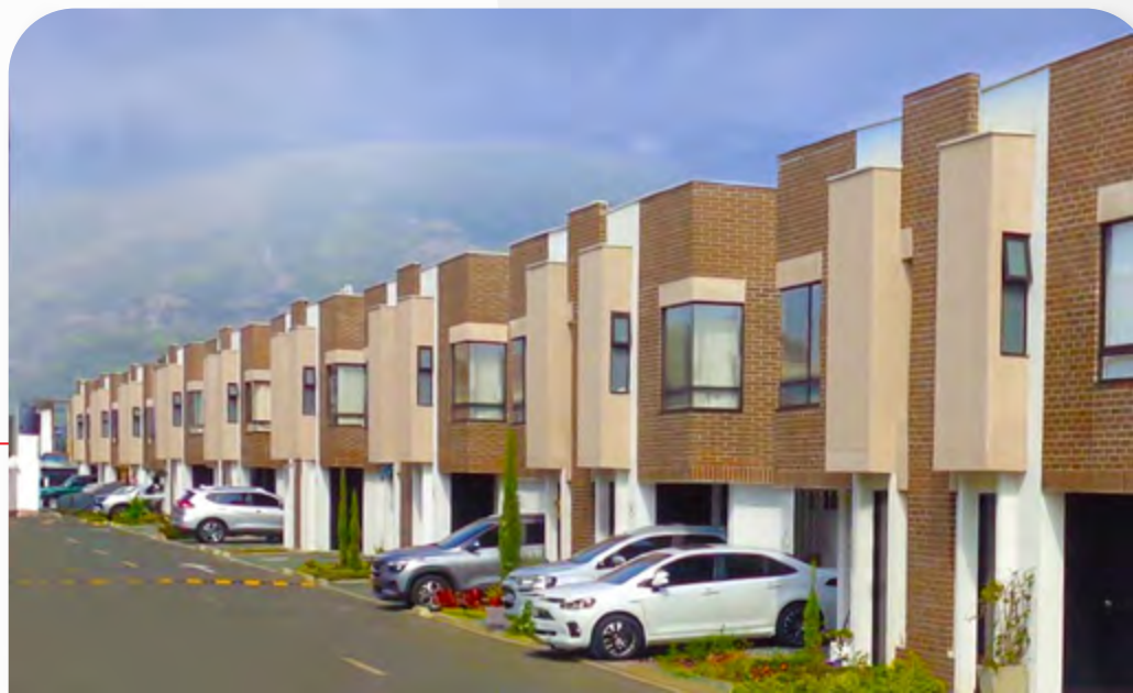
Fioreli / Mayor a VIS Constructora Bolívar Cali S.A. Jamundí, Valle del Cauca
